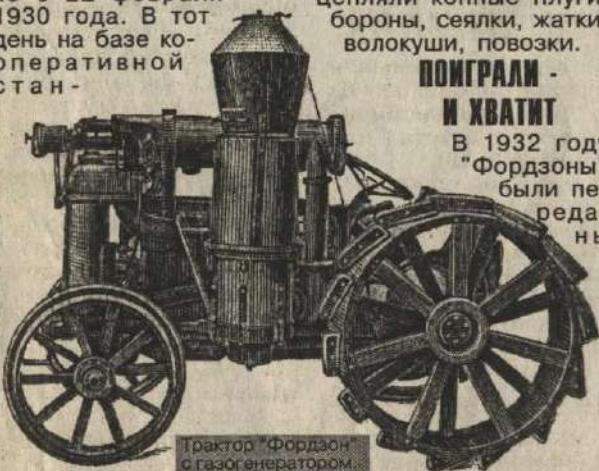
Трактор "Фордзон" с газогенератором.
